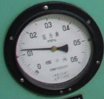
第21级后蒸汽压力
