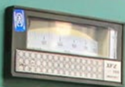
第12级后蒸汽压力
