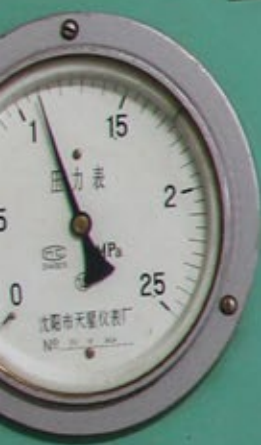
第11级后蒸汽压力左
