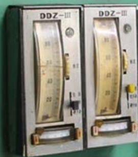
第14级后蒸汽压力
